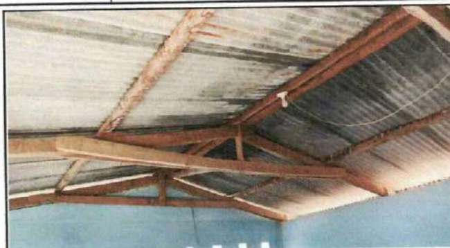
Foto 2: Se observa la estructura portante.
