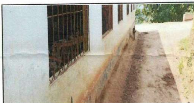
Foto 4: Se observa el desprendimiento de la pintura en la pared.
